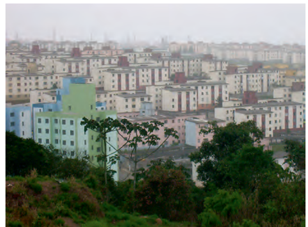
Vista geral dos conjuntos habitacionais em Cidade Tiradentes, hoje.
