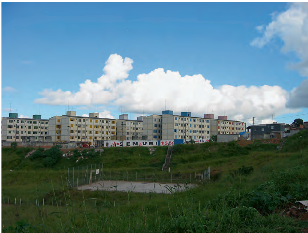
Vista geral dos conjuntos habitacionais em Cidade Tiradentes (Distritos Tipo 2)
