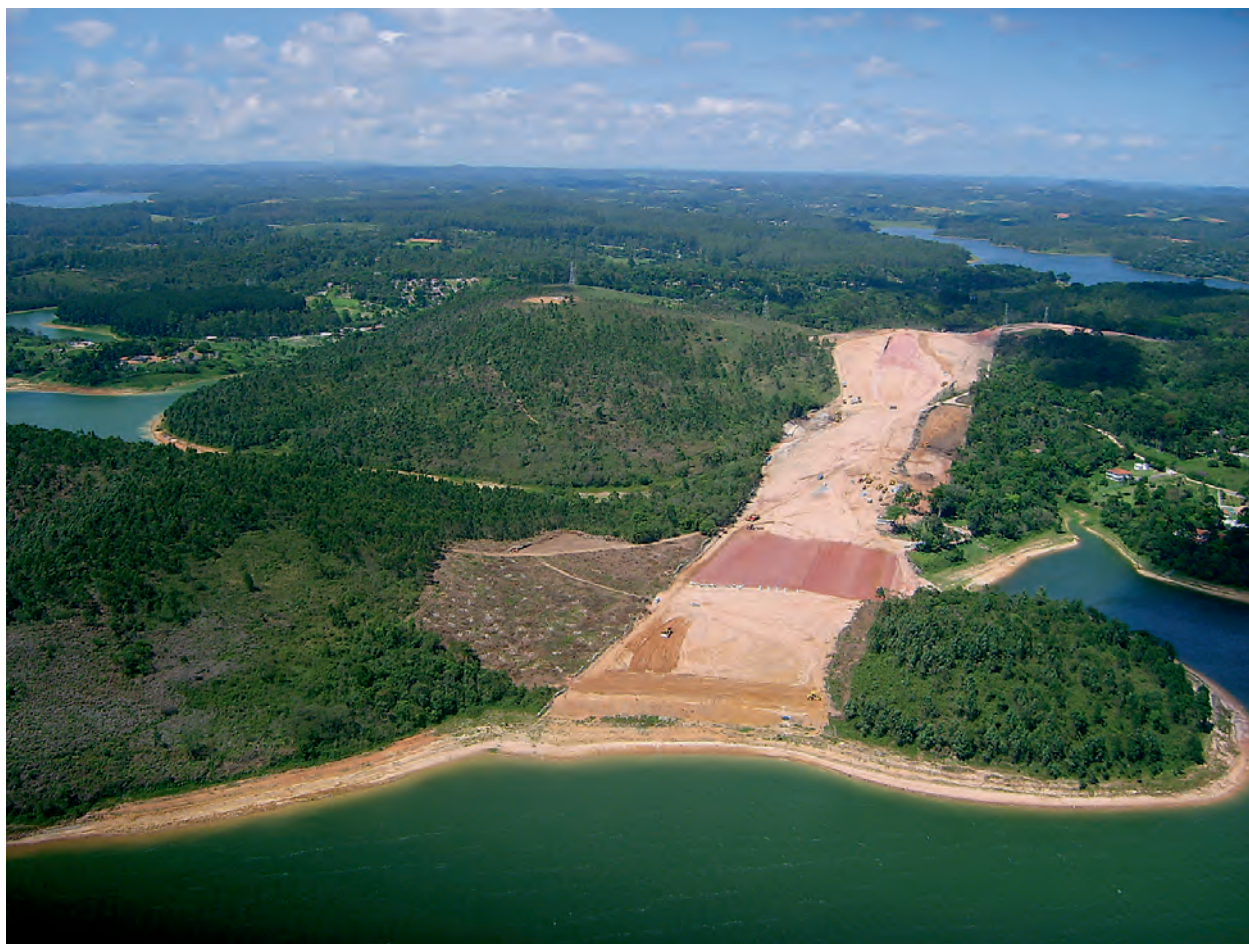
Impactos da implantação do Rodoanel Trecho Sul (Foto: DUC/SVMA)
