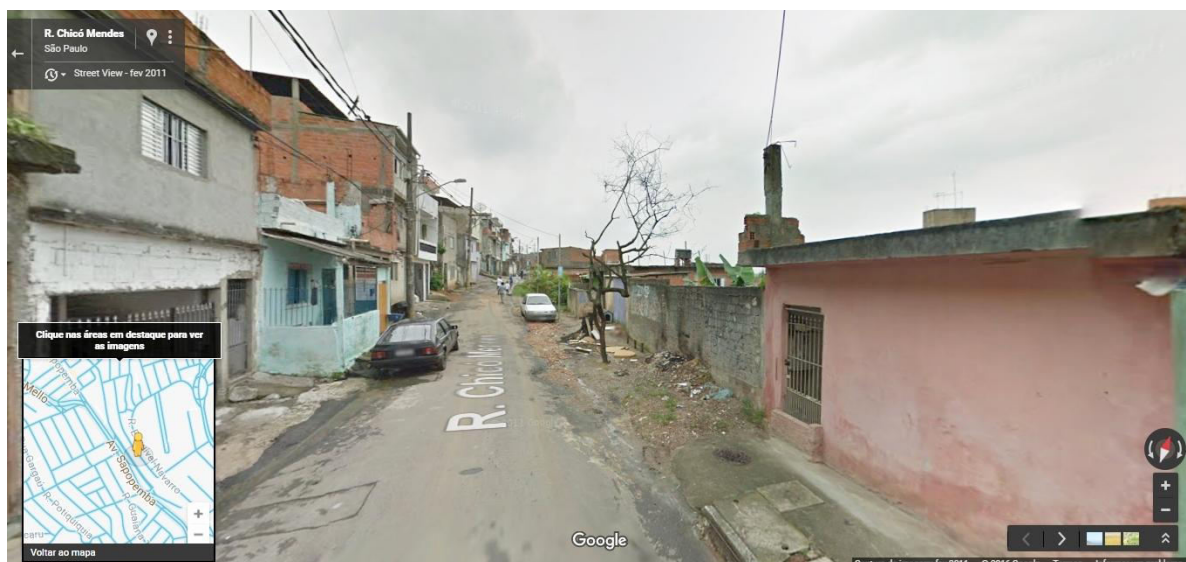
Figura 3: Tomada fotográfica do Google Street View (sentido noroeste) no ponto 2 indicado na Figura 1 (rua Chico Mendes); da mesma forma que na imagem anterior, não há diferenças construtivas ou de ocupação entre o lado esquerdo (que faz parte da favela SAP_1737) e o lado direito, que não faz parte.
