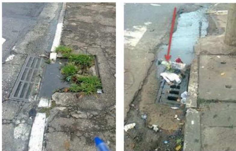
Figura 9 – Escoamento da água pluvial
