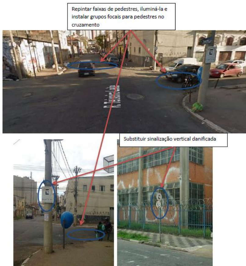
Figura 11 – Sinalização vertical e horizontal danificada
