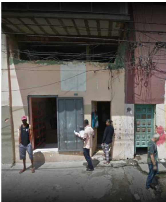
Figura 4 – Entrada do cortiço localizado na Rua do Glicério, 599
